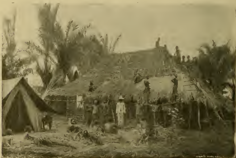
CHIMBEK EN CONSTRUCTION
